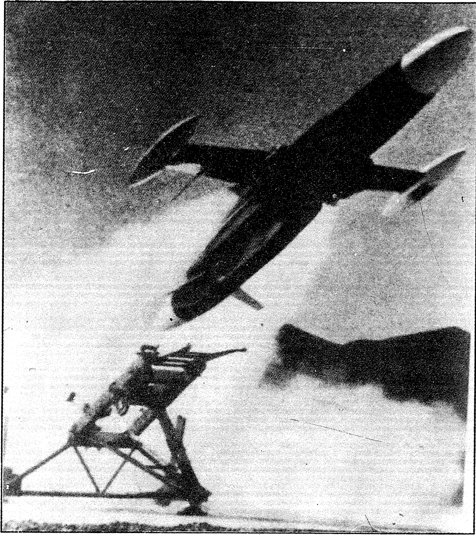
الطائرة الموجهة لاسلكيا بدون طيار ريان فابري مجهزة بمعدات الكترونية
